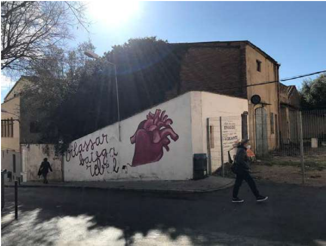
Imatge 2: Conjunt Can Jaumetó – Vista des del carrer Manuel Moreno del carreró d'accés, costat esquerre
