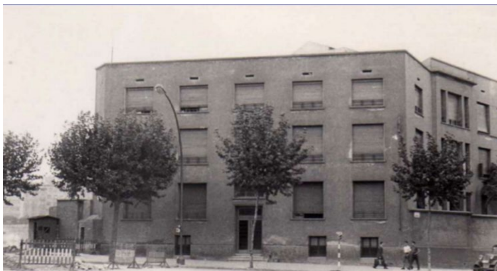
Escola al carrer d'Urgell, 262, abans de les obres de rehabilitació
