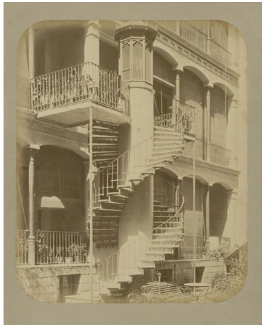
Escala interior de doble cargol de marbre i ferro de la casa Blajot (Font: Álvarez, 1874, núm. 6)
