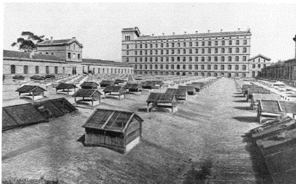
vista sobre les habitacions subterrànies
